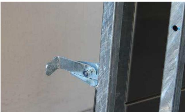
Montieren Sie die beiden Türriegel lt. Abbildung. Zwischen Anschlag und Riegel ist eine Scheibe vorgesehen. Bei der hinteren Tür ziehen Sie die Stoppmutter nur so fest, dass der Türriegel sich noch leicht bewegen kann.
