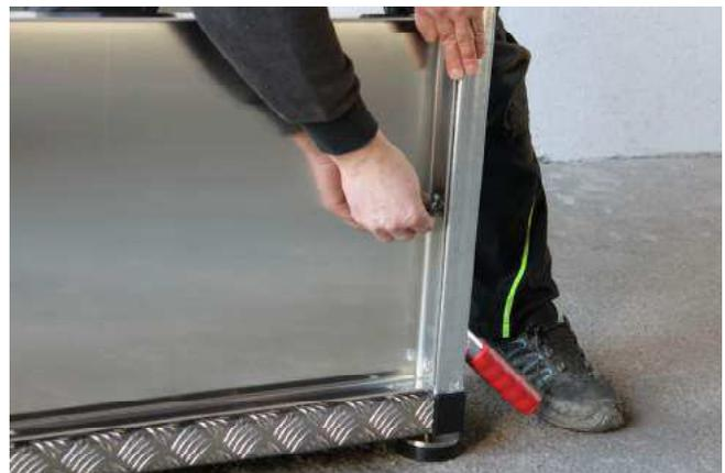
Die oberen beiden Seitenteile sind unterschiedlich. Der linke Seitenteil hat oben 3 Bohrungen, der rechte hat oben 2 Bohrungen. Platzieren Sie die oberen Seitenteile ebenfalls mit der glatten Fläche nach innen, achten Sie dabei auf die Kabel. Befestigen Sie die Teile ebenfalls mit je 3 Schrauben vorne und hinten. Ziehen Sie die Schrauben noch nicht fest.
